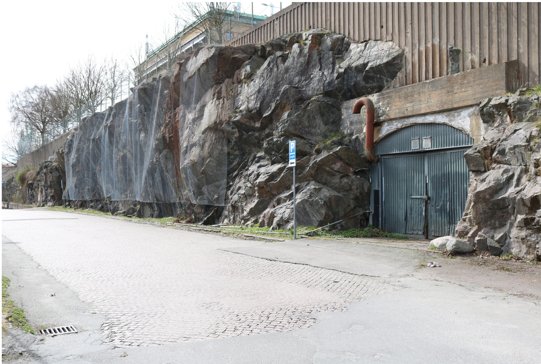
Den asfalterade Kungälvsgatan, med stora partier av synlig underliggande smågatsten. Utmed gatan sträcker sig en bergskärning försedd med två öppningar. Den ena porten syns i bild. Berget jämnas upp till av mönsterjutna terrassmurar av betong.
