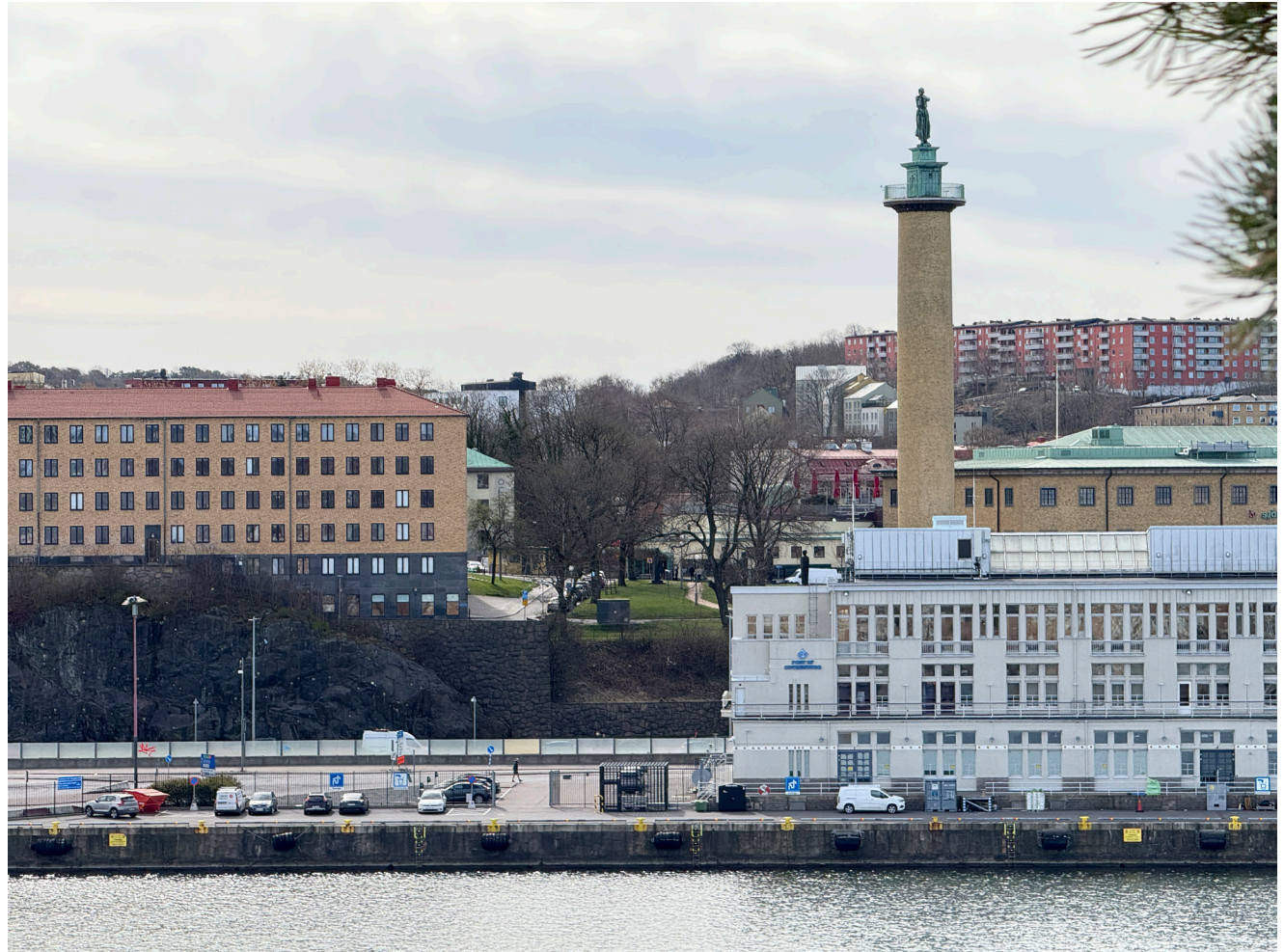
Stigbergets vertikala front mot älven med hög bergskärning och anslutande terrassmurar. Bergskärningen skiljs från hamnlandskapet i förgrunden av Oscarsleden. Till höger, bakom det vitputsade Amerikaskjulet, skymtar Sjöfartsmuseet med Sjömanstornet. Till vänster syns kvarteret med fd biografen Fyren. Mellan byggnaderna ligger resterna av Gamla varvsparken.
