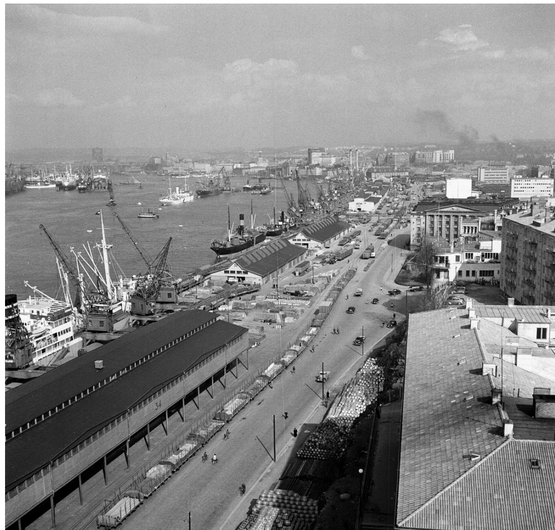
Stigbergskajen fotograferad från Sjömanstornet. Taket nere till höger i bild tillhör Sjöfartsmuseet. Nedanförlöper vägen som under 1960-talet skulle byggas ut till dagens Oscarsleden. Foto K.W. Gullers 1946–47. Nordiska museets bildarkiv.
